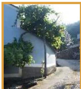
**Suxerencia:** Observar el ubicación dos fornos de leña nel pobo, sobresalindo das paredes mestras das casas y atizaos dende dentro da casa. Os sous perfiles curvos, en ocasiós baxo emparraos, señalan a presencia de cámaras de pranta semicircular y estructura abovedada, con cuberta de pizarra.
