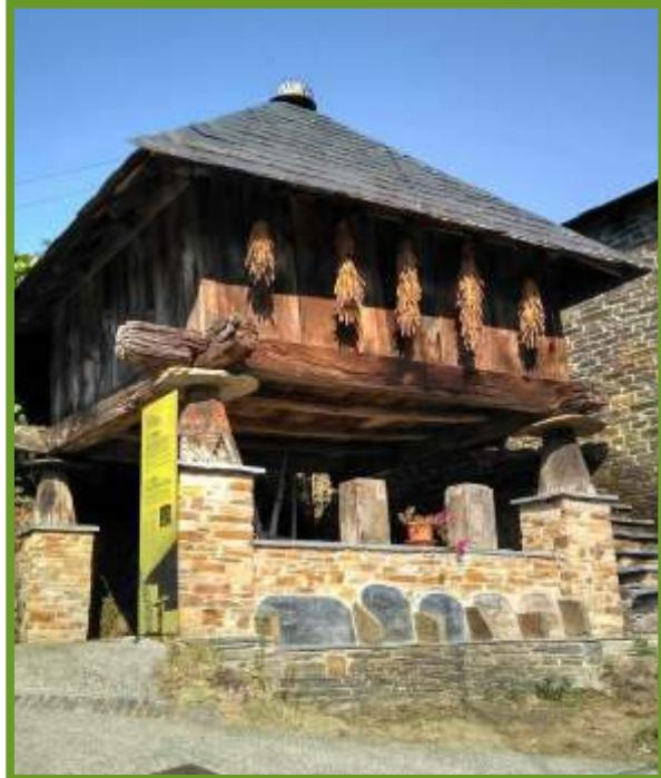
Nos horros, el meiz secábase en estructuras fora da súa cámara de secao y almacenábase nel sou interior úa vez seco, dada a estanqueidá da cámara al nun presentar circulación d'aire nel sou interior. A solución pral secao interior na cámara sería deixar abertos durante un tempo portelos y ventanales removendo el grao a miudo. El sito d'estos graneros en ocasióis resulta mui cercano á casa ou como parte central del patio condo este s'atopa amurao.
