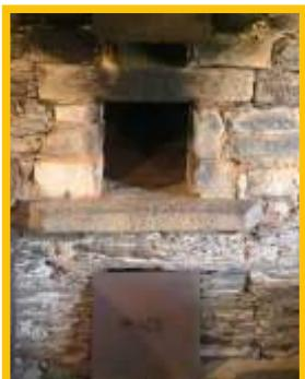
**Suxerencia:** Dada a presencia de pezas de madera que podían prender col lume da cocía, el forno ten úa visera de pizarra que frena a subida das mochicas hacia a parte alta da estancia y con un cinceiro pral depósito y apagao das brasas y a cinza.
