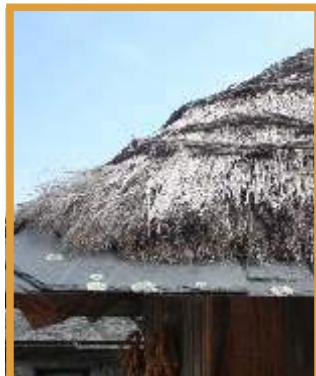
**Suxerencia:** Observar con detalle a cuberta de paya de centén del horro, cuyo proceso de cubrición requer de cordas d'esa paya ou bringas retorcidas y dispostas en paralelo con pouca separación entre sí; resultan d'interés os aperos da labranza colocaos baxo a cámara del horro, en especial el carro del país.
