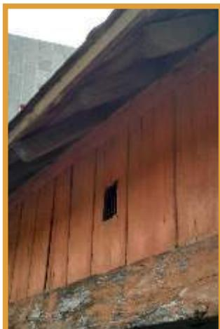
**Suxerencia:** Observar as aberturas que garantizan el paso preciso y necesario d'aire na cámara d'almacenaxe; nos costales del horro fainse aberturas pral aireación interna da cámara, como simples furaos ou con celosías trabayadas, cuyo efecto pódese reforzar col apertura da porta pequena ou portelo que sirve d'entrada.
