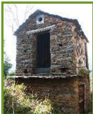
*Suxerencia: Deterse ante dalgúas das singularidades constructivas, como el cabazo a dúas augas de Santesteba, feito hacia el ano 1940. Na súa cámara de secao almacenábanse as espigas pral sou secao, tras el que se colocaban en arcas de madera pral desgrane mediante el golpeao con mazos de madera, de mayor comodidá y rendemento que de forma manual mediante a presión exercida cos didos.*
